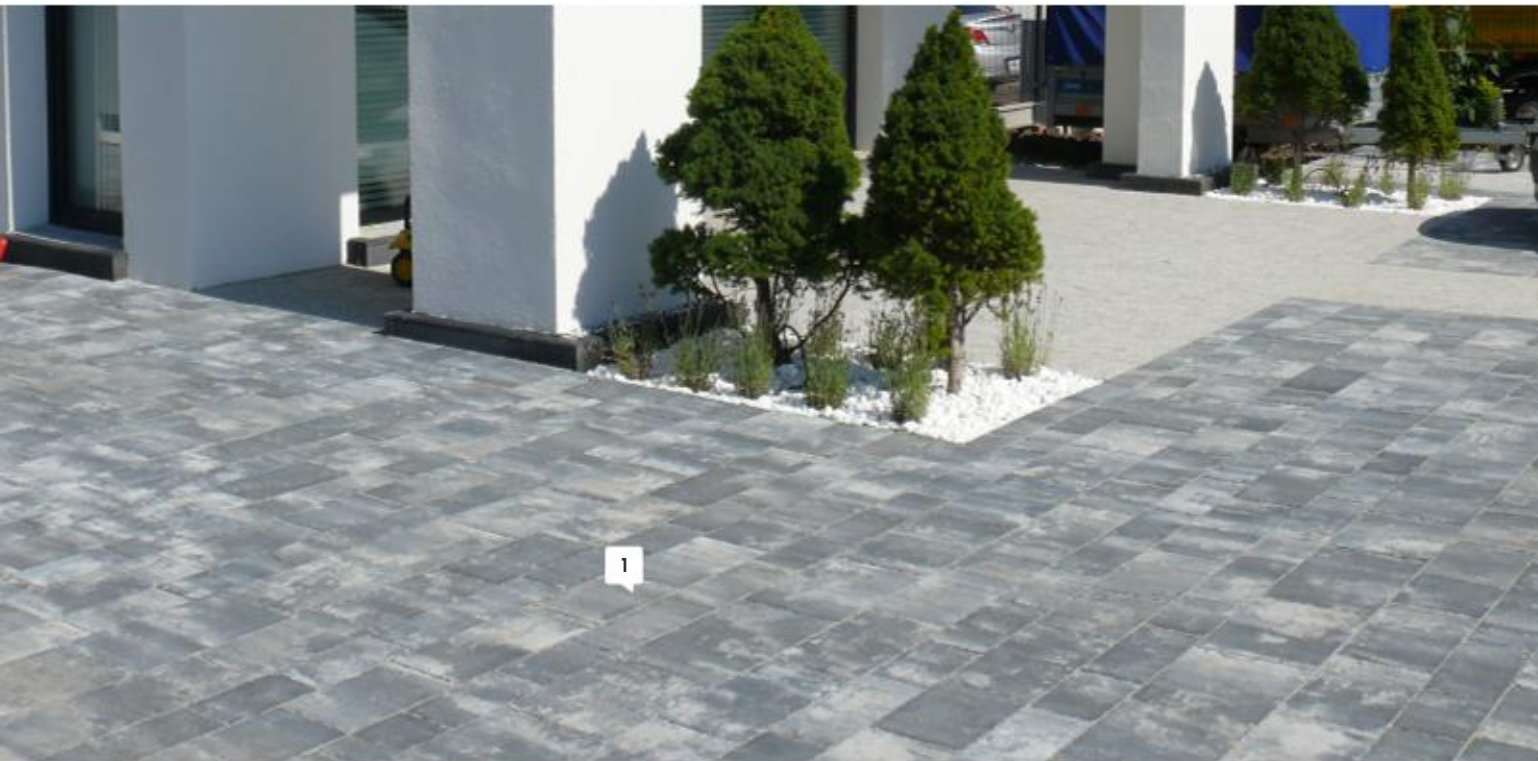
1 | Via Stelle Mix A6 Marago
